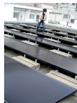
パネルの点検 2022.5.16
